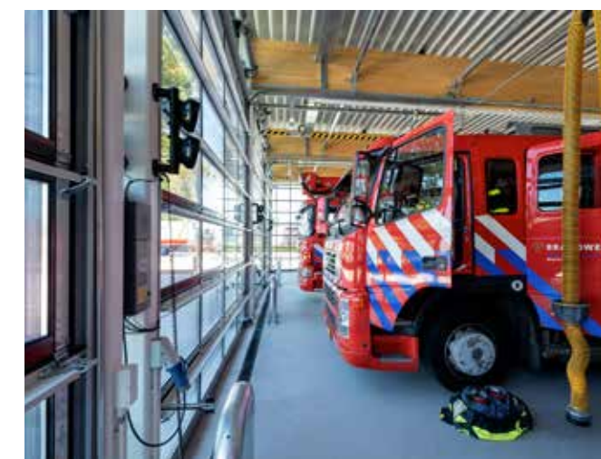
Een etalage voor brandweerauto's, zo omschrijven Mark Schrurs en Eric van Pelt van Van Pelt architecten de transparante gevel van de nieuwe brandweerkazerne in Waalwijk.
