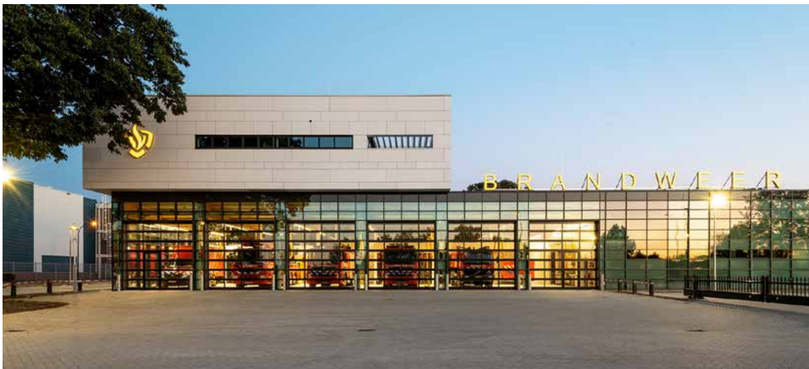
In een jaar tijd heeft bouwbedrijf Kleijngeld de nieuwe brandweerkazerne langs de A59 in Waalwijk gerealiseerd, aan de hand van het ontwerp van Van Pelt architecten. (Beeld: LEEF Fotografie)
