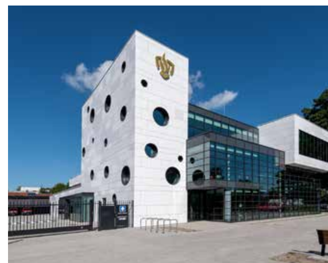
Een gedeelte van de gevel is voorzien van witte gevelpanelen die beschikken over drie glansgraden: mat, zijdeglans en glanzend.
